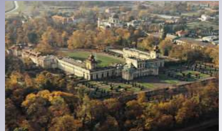
Pałac w Wilanowie
